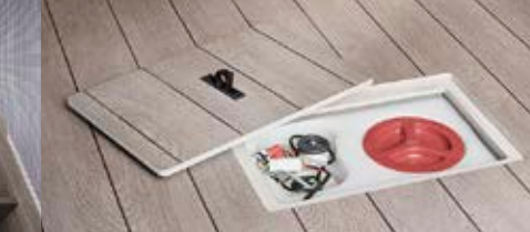
5 Apertura per pulizia serbatoio dell'acqua chiara
