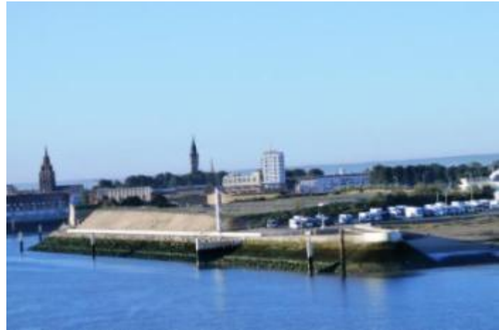
Calais Area di sosta vista dal traghetto
