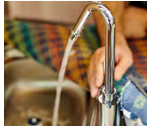
Corretta installazione degli impianti idraulici.
